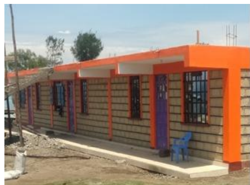
Neues Gebäude für Mitarbeiter in Strong Tower
